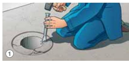
1 Монтаж противопожарного трапа R 120 выполняется в несколько этапов. После сверления отверстия в проеме вокруг него просверливается еще одна окружность глубиной ок. 20 мм. Образовавшаяся кромка отбивается при помощи долота.
