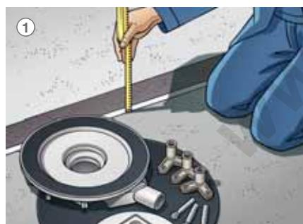
1 Измерить высоту напольной конструкции, здесь: 85 мм.
