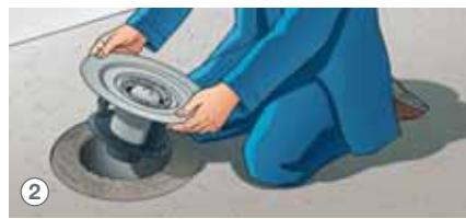
2 Затем на оработанную окружность нанести раствор и вставить в проем противопожарный трап.
