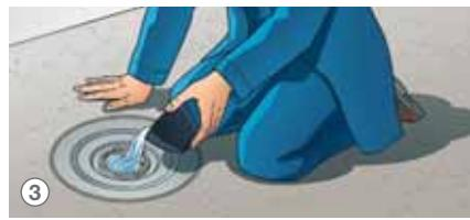
3 Фланец при этом должен быть заподлицо с полом. Фиксацию компонента обеспечивают пружинные зажимы. В завершение заполнить смонтированный трап водой и установить защитную крышку. Внимание: противопожарный трап функционирует только при заполненном водой сифоне.
