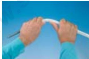
Изгиб при помощи внешней спиральной пружины
