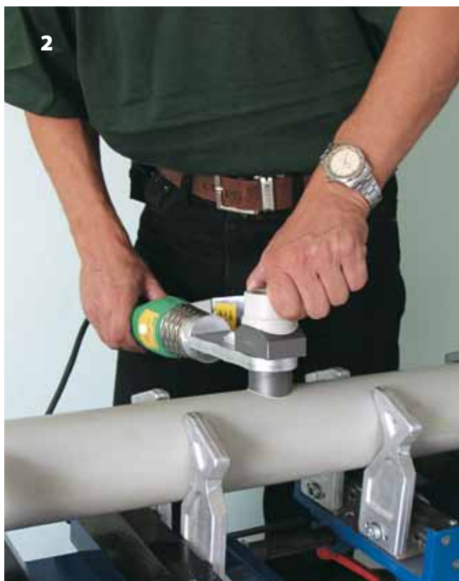
2 Зачистить. Если применяется труба Stabi, то у высверленного отверстия необходимо скосить фаску. Очистить и обезжирить фасонную часть и высверленное отверстие.
